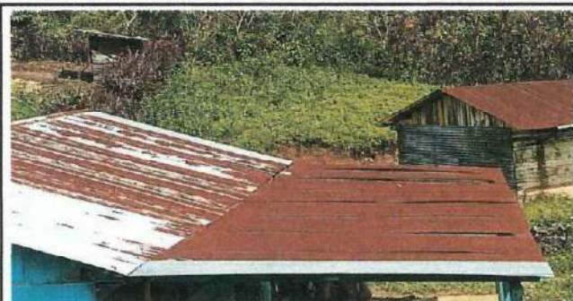
Foto 3: Sustitucion de cubierto de lamina.
