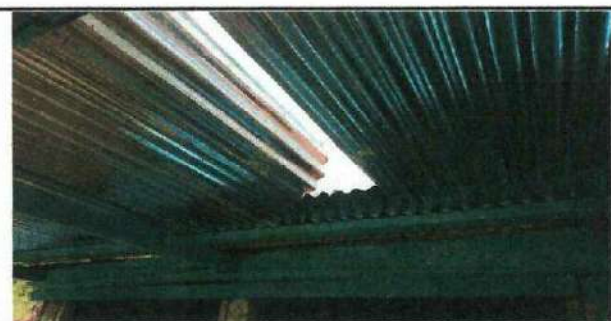
Foto 5: Sustitucion de la estructura metalica del techo.
