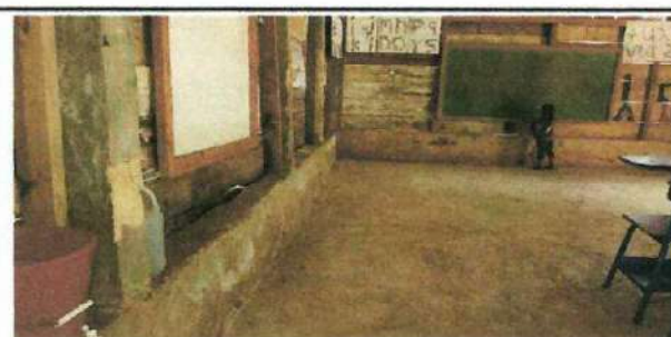
Foto 6. Mantenimiento de columnas.
