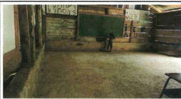
Foto 4: Sustitucion del piso de torta de cemento.
