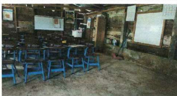
Foto 2: Rehabilitacion de paredes.
